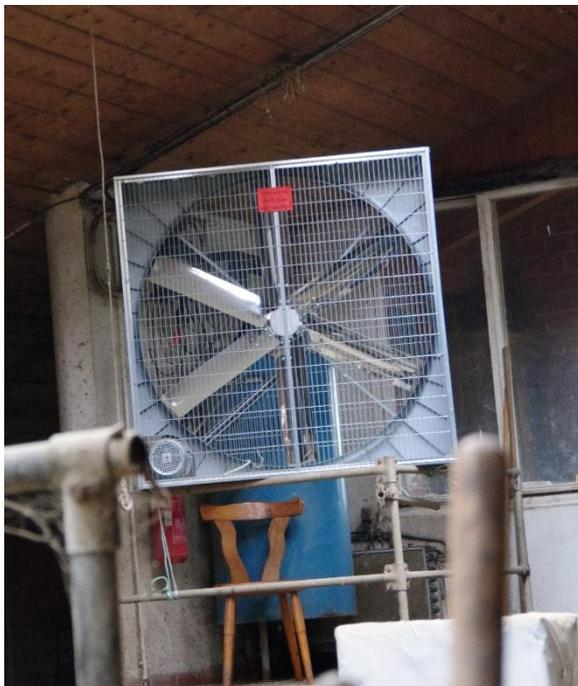
Abb. 13: Ventilator zur Reduzierung von Hitzestress im Betrieb D
