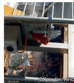
Abb. 82: Beispiel eines größeren Mazerators auf einem Betrieb während der finalen Reinigung
