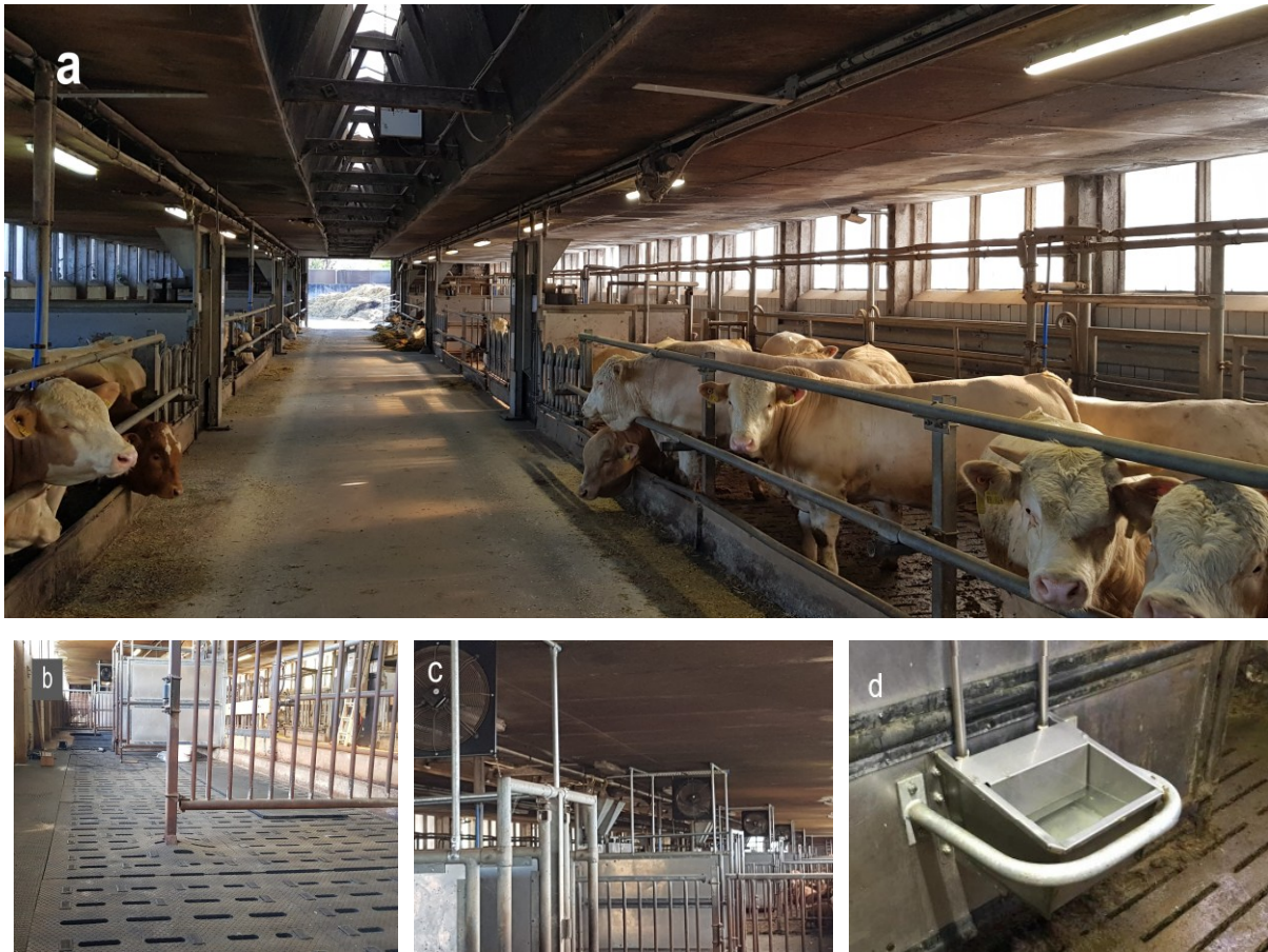
Abbildung 70 Impressionen aus dem geschlossenen Stall mit Einflächenbuchten. a: Begehbare Futtertisch mit den jeweiligen Buchten zu beiden Seiten. b: Betonspaltenboden mit emissionsmindernden Gummibodenbelägen. c: Ventilatoren sind in Längsrichtung über dem Tierbereich angebracht. d: Jede Bucht verfügt zusätzlich zu den Tränkschalen über eine Trogtränke.
